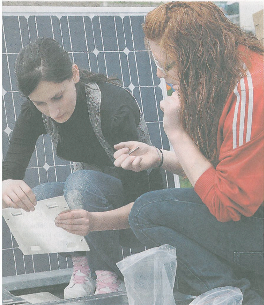
Wauwiler Schülerinnen montieren die Solarstromanlage auf dem Dach des Infopavillons der Pfahlbausiedlung.
